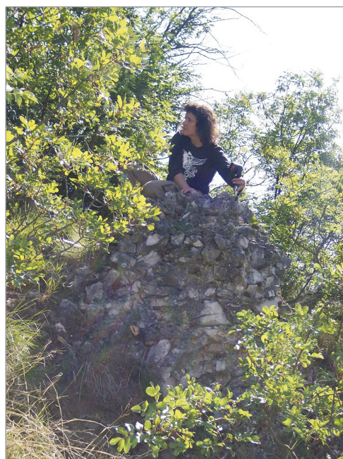
Fig. 31: Villaggio del Pescatore. Palazzo d'Attila (n. 4). Contrafforte (foto S. Mauro).
