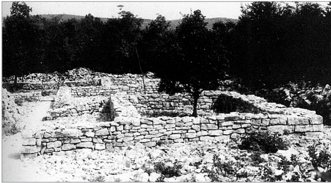
Fig. 50: Duino-Aurisina, Trieste. Casa della Torre Piezometrica (da ZUBINI 2005).
