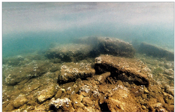
Fig. 66: Muggia. Stramare (n. 16). Particolare della gettata di blocchi a protezione del terrazzo inferiore, oggi sommerso (foto Naukleros).
